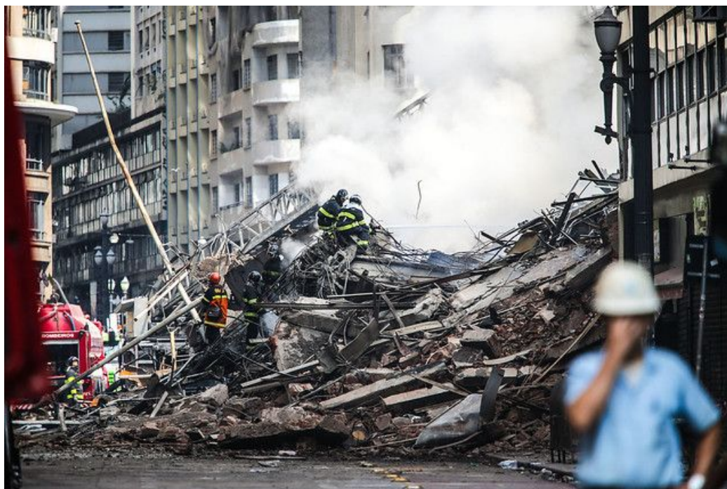
Figura 02 - Destroços do Edifício Wilton Paes de Almeida
