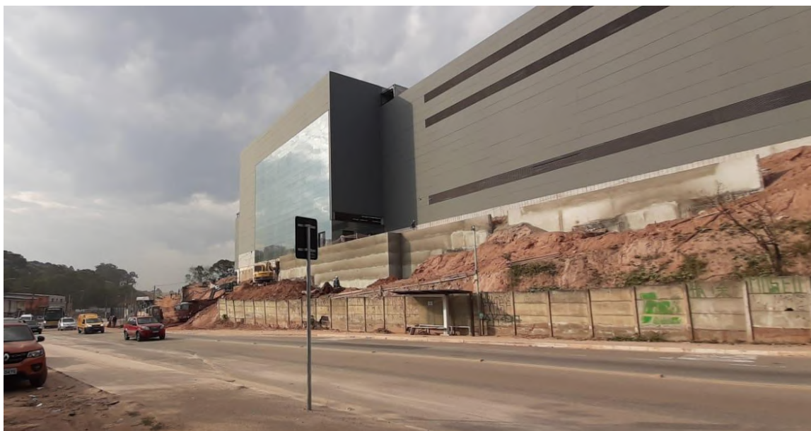
Foto 11: Pólo comercial em fase de obras
