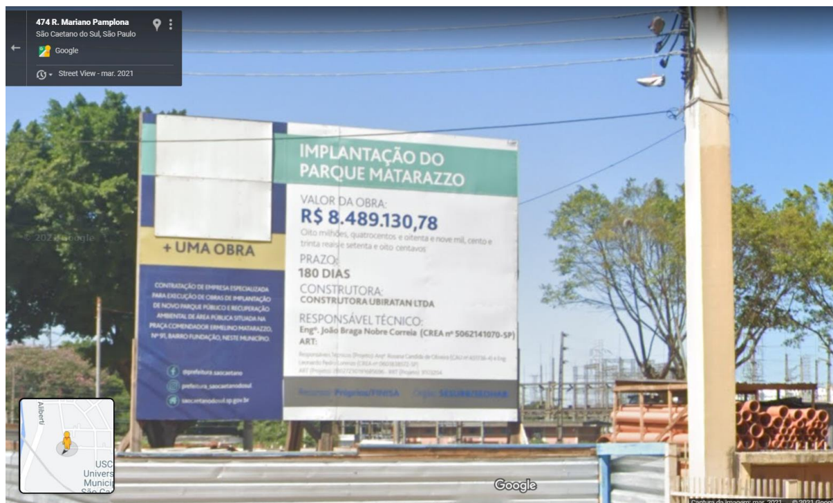
Imagem - obras iniciadas em área contaminada. Fonte: plataforma Google Streetview
