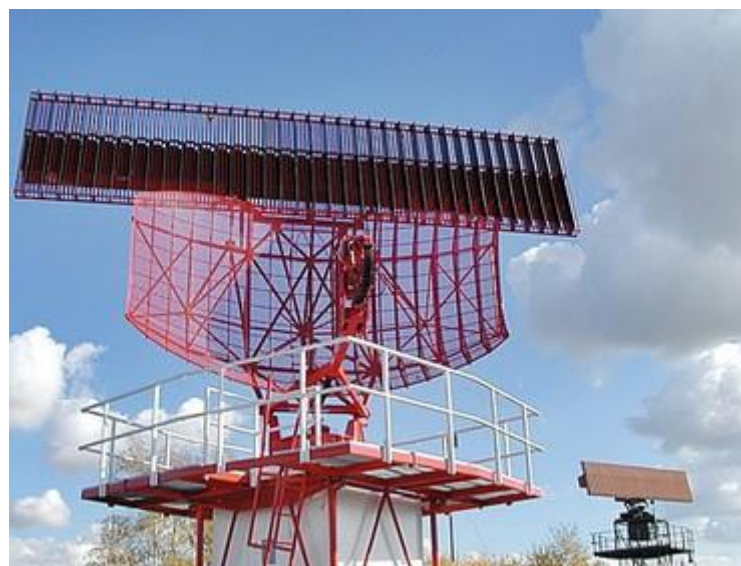
Figura 4 - Radar SSR com movimento giratório da antena
