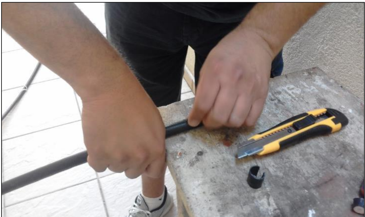
Figura 77 - Desencapamento do cabo
